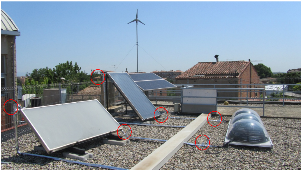
Imatge 68. Fotografia de l'aula d'energies renovables. En vermell, les sondes de temperatura
