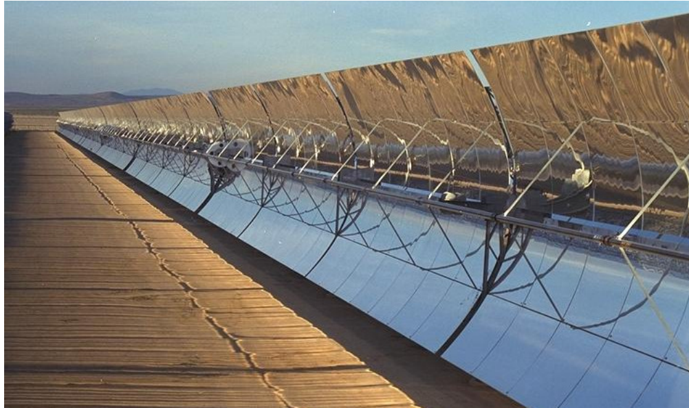
Imatge 20. Fotografia de detall dels col·lectors de concentració de Solar Energy Generating Systems (SEGS) , que és la instal·lació d'energia solar més gran al món. Té 9 plantes d'energia solar i està situada al desert de Mojave a l'estat de Califòrnia, EUA. La insolació es troba entre les més elevades d'E.U.A. i el conjunt de la instal·lació té una potència de 354 MW, de manera que pot alimentar 230.000 habitatges.
