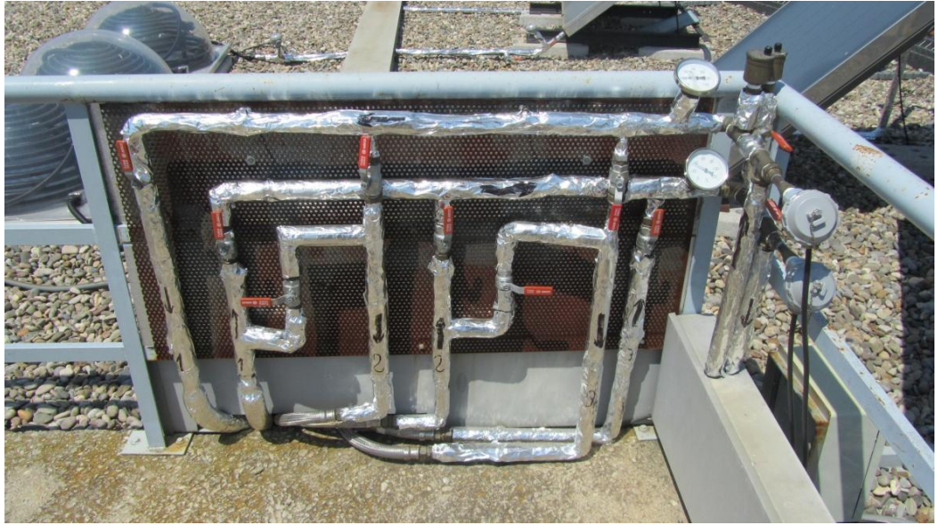
Imatge 74. Fotografia del piano de vàlvules quan els col·lectors estan connectats en paral·lel.
