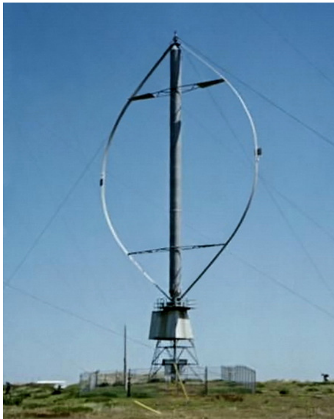
Imatge 45. Fotografia d'un aerogenerador d'eix vertical del tipus Darrieus a les Illes de la Magdalena, Canadà.
