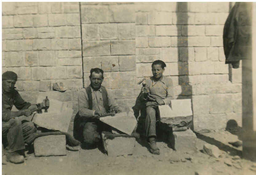
Picapedrers treballant a l'obra
