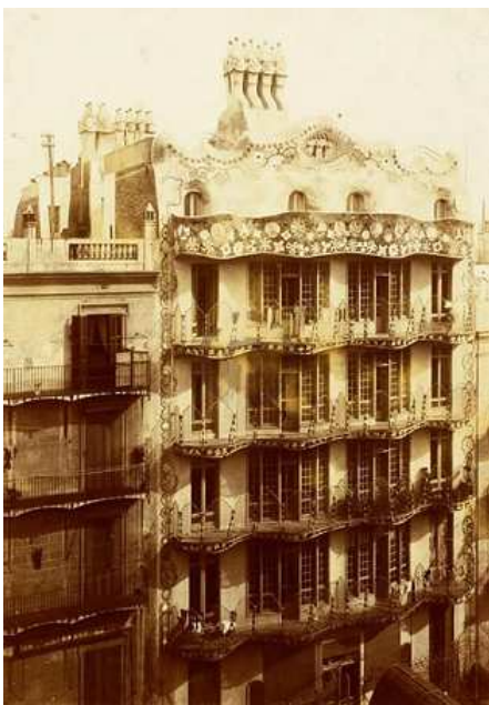
Façana posterior Casa Batlló 1900-1915 (ICUB)
