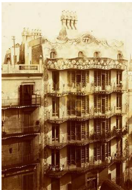
Façana posterior Casa Batlló 1900-1915 (ICUB)
