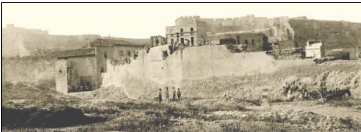
Treballs d'enderrocament de la muralla de Remolins (1909)
