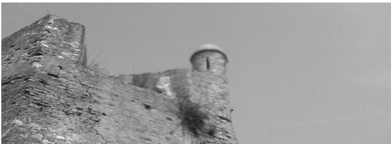
Baluard sud de la segona avançada
