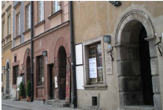
Portes que s'obren manualment
