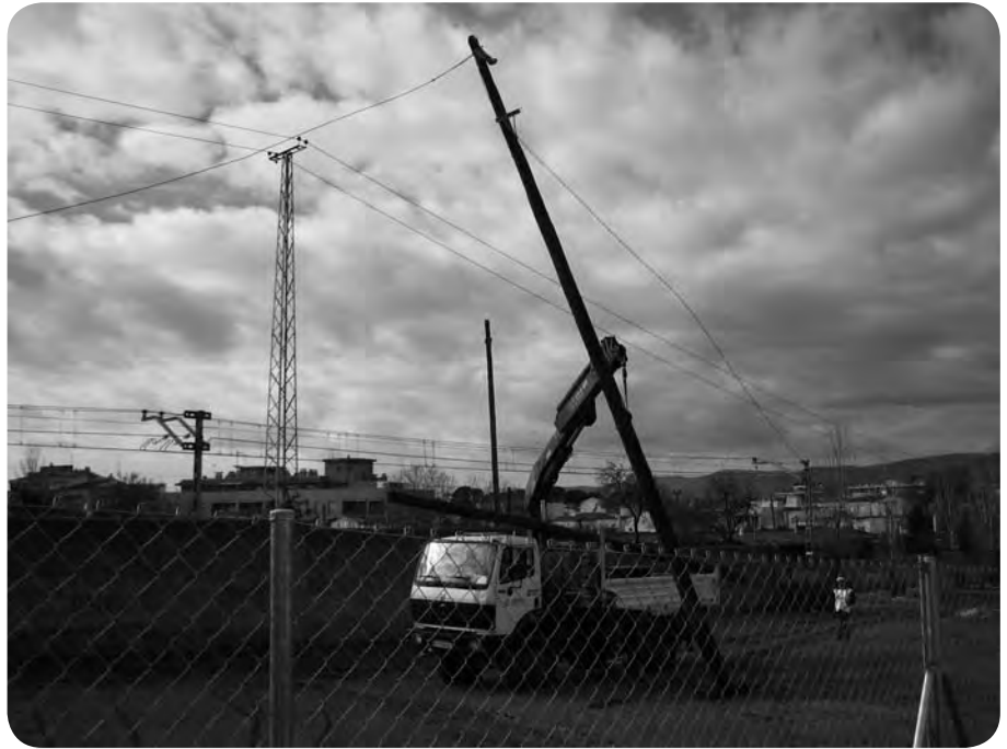
Els operaris treient el pal elèctric
