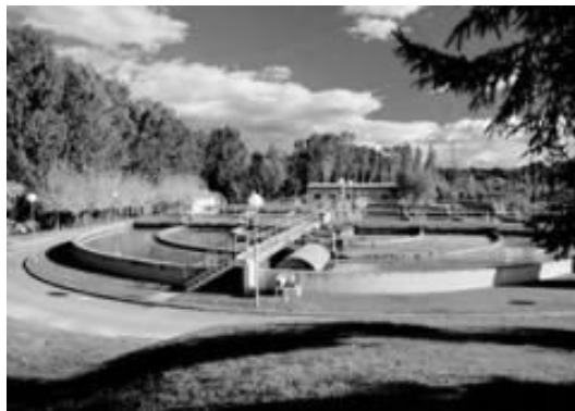
Vista de la depuradora de Torelló
