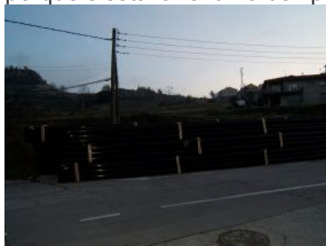
Tram de carrer on s'està treballant
