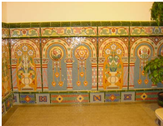
Vista general d'una de les parets laterals
