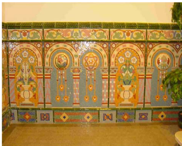
Vista general de l'arrimador del vestíbul
