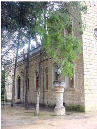
Vista general de la façana dels jardins
