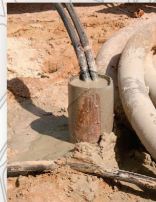
Font: La casa sostenible. http://www.lacasasostenible.com/climatizacion-geotermica.html
