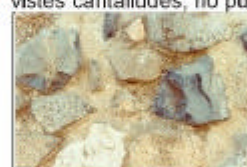
Pedres de molt diverses mides irregulars barrejades amb morter o ciment
