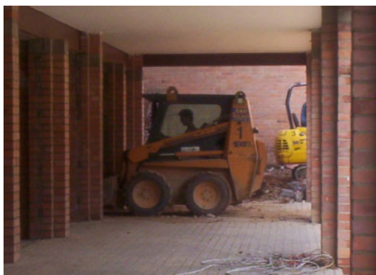
Un treballador amb l'excavadora
