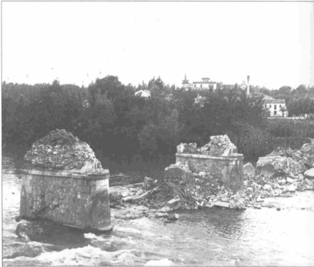
El pont un cop enderrocat.
