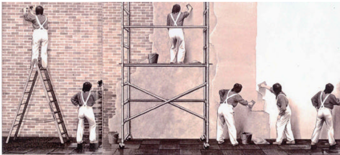
Figura 5.3a. Preparació del mur
