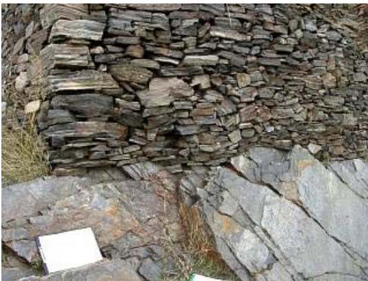
La quarsita , roca molt dura i compacta, és emprada com a material de construcció per fer parets. El mas de can Rabassers de dalt està fet amb quarsita
