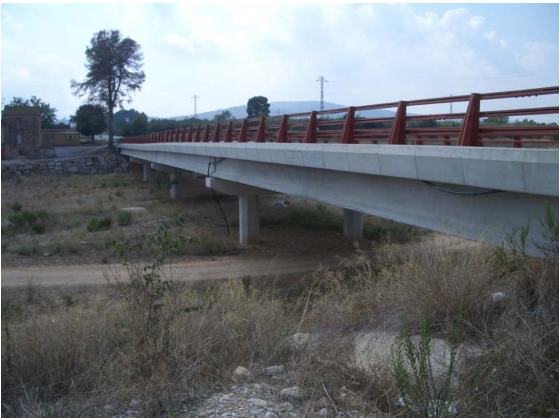
Aspecte actual del pont al Bc de La Galera
