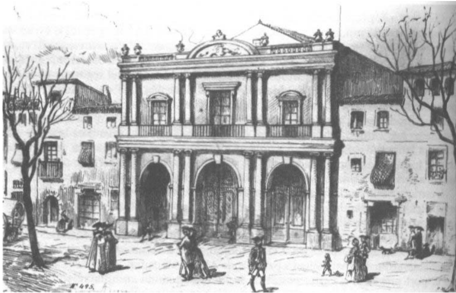
Façana barroca del Teatre de la Santa Creu, avui Teatre Principal
