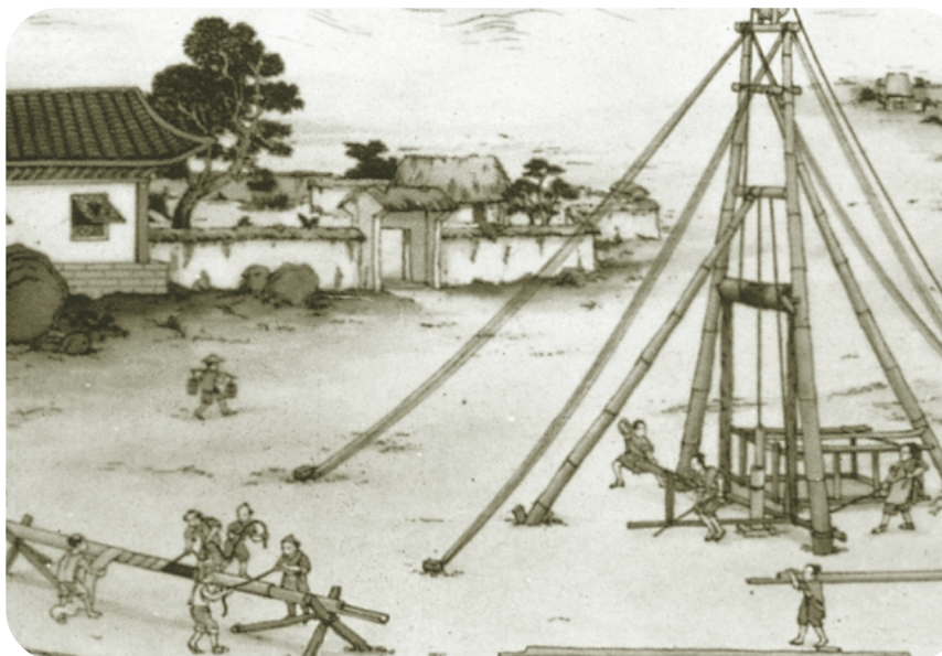
Instal·lació d'una canonada de bambú a la Xina (segle X)
