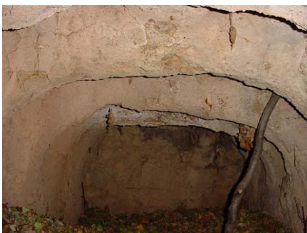
Forn de rajols: cambra de combustió i arcs que aguanten l'enreixat
