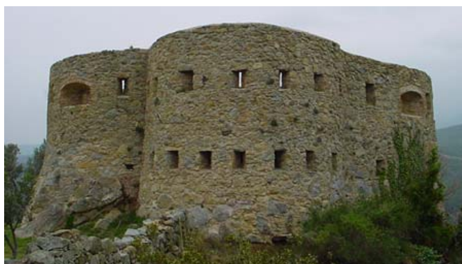
Torre de Carabanxel. Vista est.
