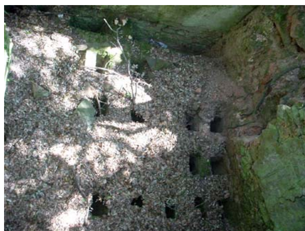
Forn de rajols: enreixat damunt del qual es col·locaven els rajols o les teules
