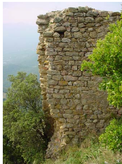
Penjada sobre l'espadat de migjorn, la torre del castell desafia el pas del temps
