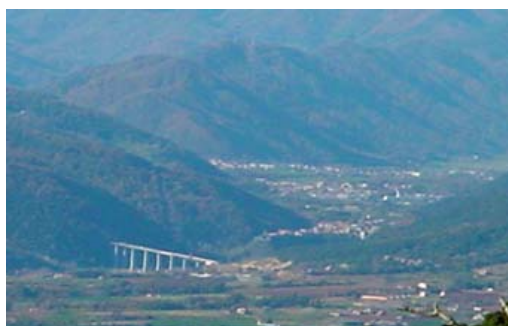
Viaducte de Castellfolit de la Roca
