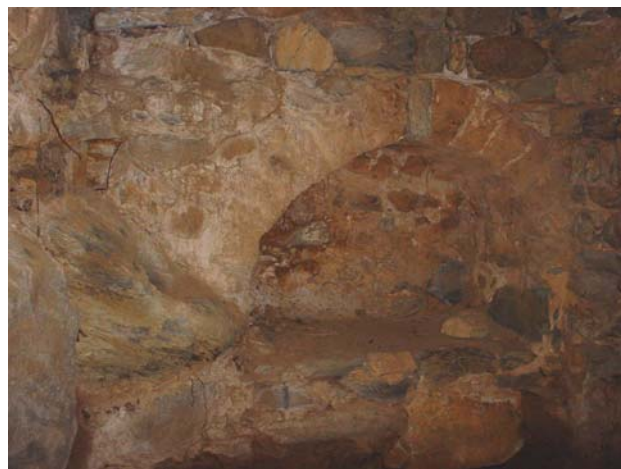
Nínxol al mur de ponent
