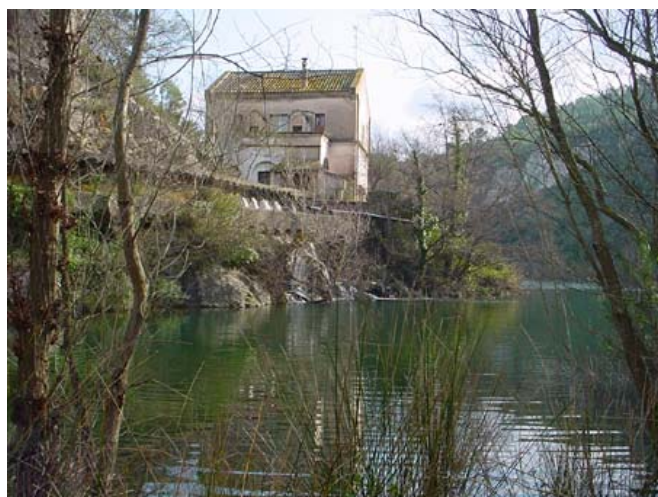
El molí d'en Miquel, amb el canal i el salt d'aigua, transformat en central hidroelèctrica
