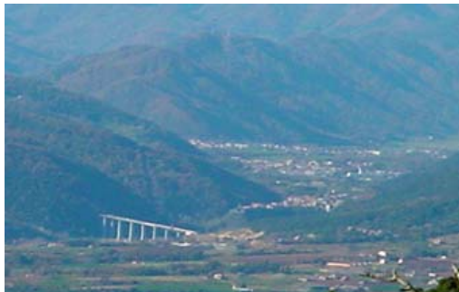
Viaducte de Castellfollit de la Roca
