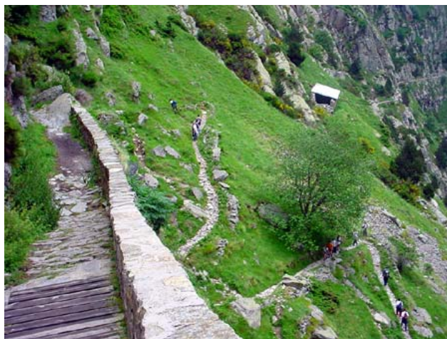
Poc abans del Salt del Sastre s'observa l'enllosat del camí, els murs de contenció i el sistema d'evacuació d'aigua
