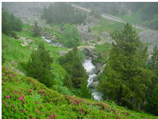
L'antic pont dels Tres Molins sobre el riu Núria i el cremallera, la construcció del qual, ha fet desviar el recorregut del camí
