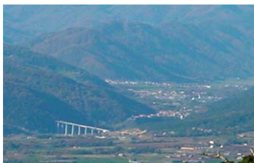
Viaducte de Castellfollit de la Roca
