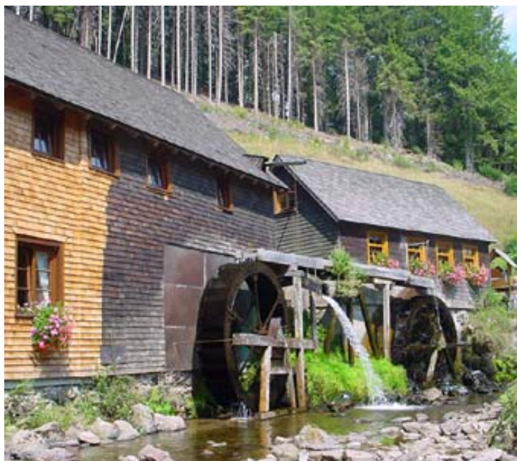
Una serradora moguda amb rodes hidràuliques verticals a Hexenlochmühle, a la Selva Negra alemanya
