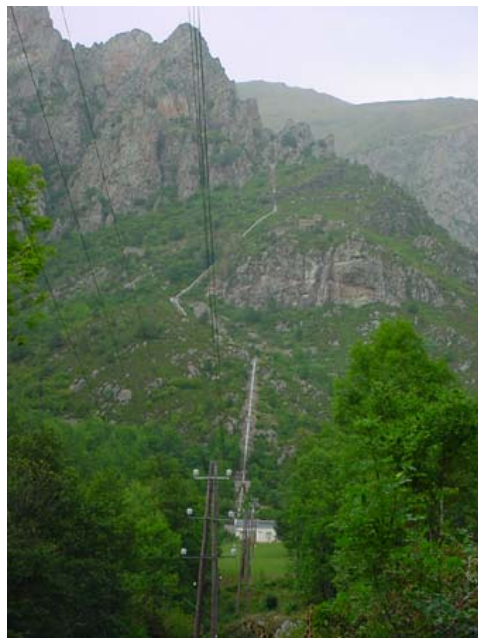
Central hidroelèctrica de Daió
