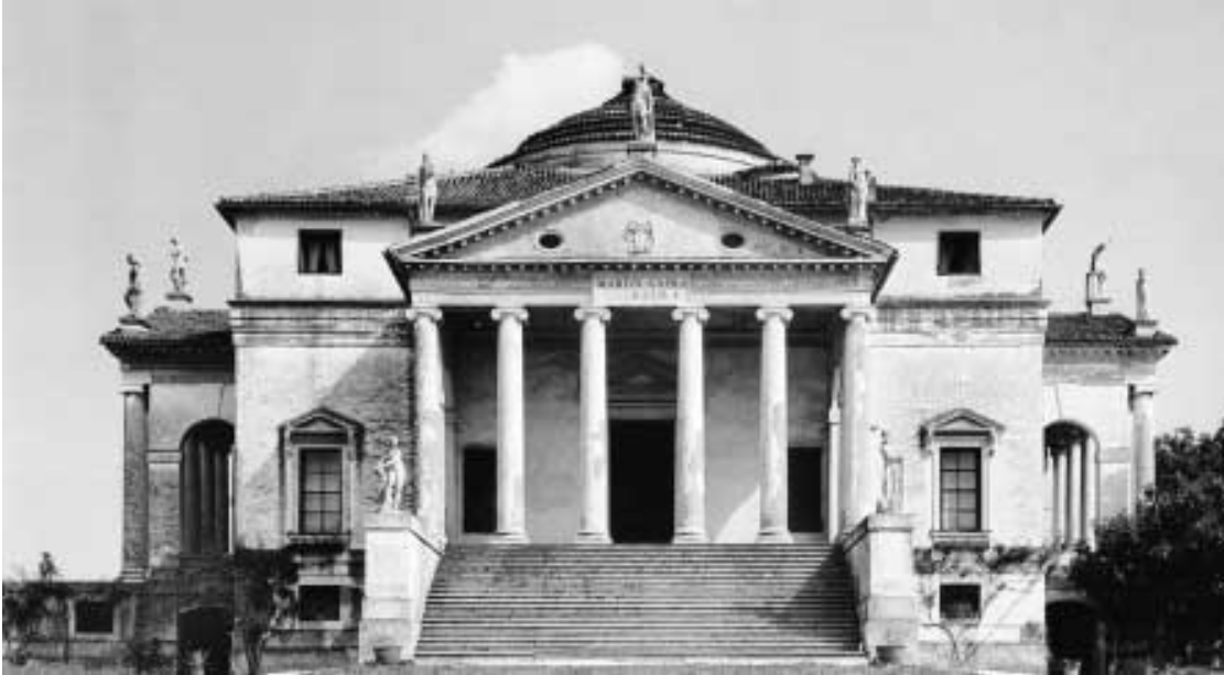
Obra 4: Villa Rotonda , d'A. Palladio.
