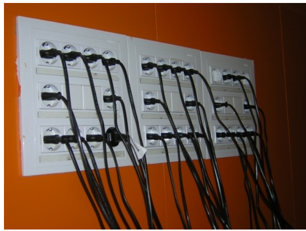
foto 10. detall endolls amb fonts d'alimentació connectades
