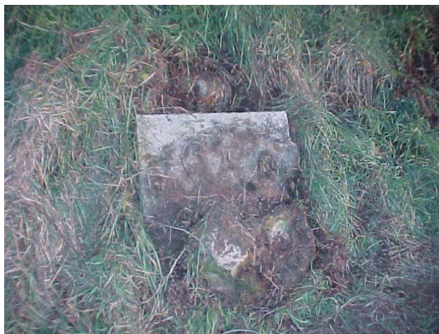
A l'entrada del refugi hi ha aquesta llosa de formigó i just a sobre es veu la volta d'obra vista.
