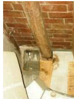
Imatge del forat de ventilació de la coberta, que correspon al forat dels medallons de la façana.
