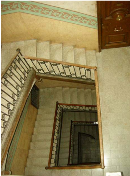
Vista de l'escala des del quart pis. La llum d'aquest replà és natural i prové de la claraboia del sostre.
