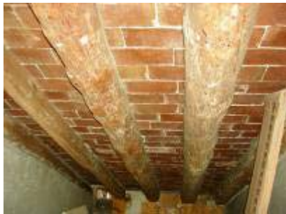
Imatge de l'embigat de la coberta inclinada amb la capa de maons.
