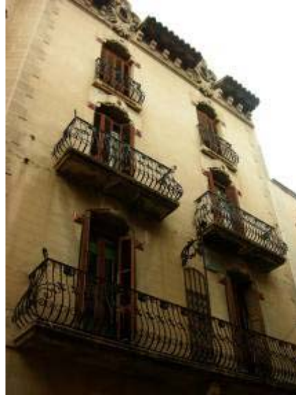
Imatges de les dues façanes. Podem veure la composició dels balcons de forma geomètrica i imitant la forma d'un triangle
