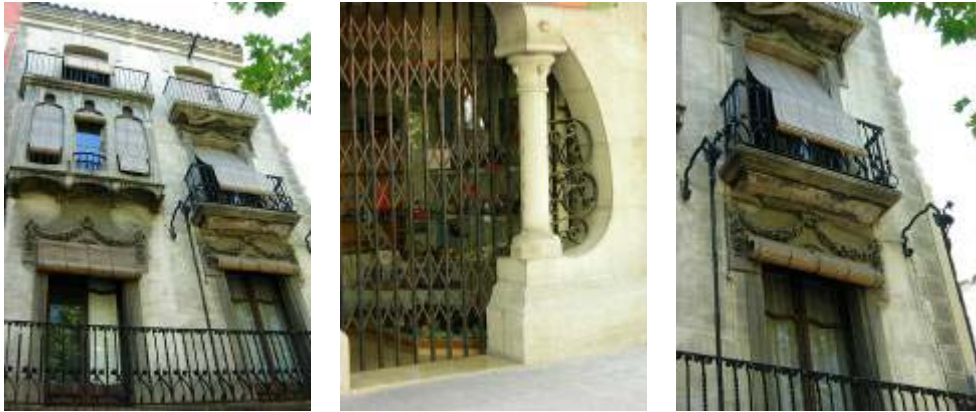
Edifici de “Cal Blay”, a la Rambla Sant Isidre nº 10 construït el 1904. Podem veure la construcció amb carreus i les ornamentacions de sobre les obertures.
