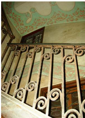
Imatge d'un tros de la barana, i al fons podem veure una finestra i l'esgrafiats del sostre
