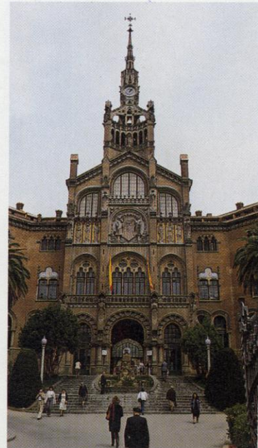
Empresa pública (Hospital de Sant Pau de Barcelona)
